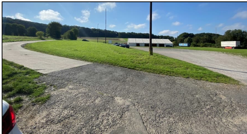
Abbildung 17: Asphaltierte Zufahrt zum Festplatz mit weiterführendem Betonplattenweg
