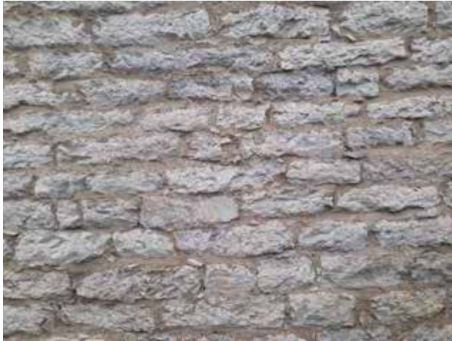
Traditionelles Kalksteinmauerwerk Langgöns
