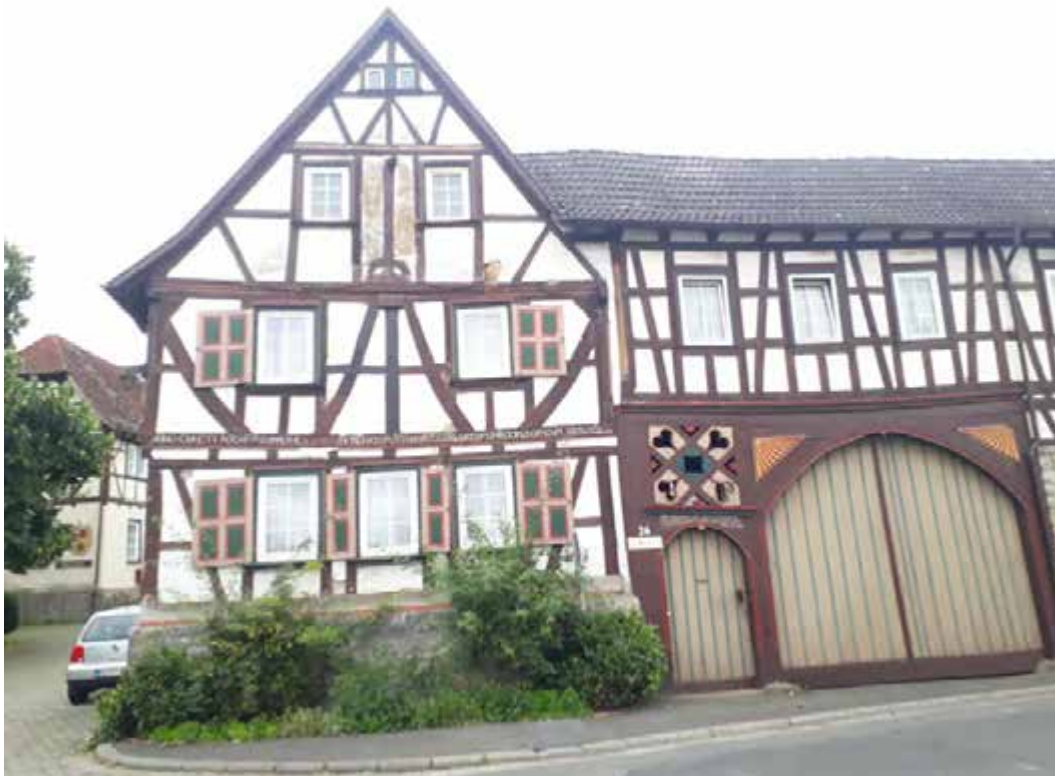
3-seit Anlage mit überbautem Torhaus (Niederkleen)
